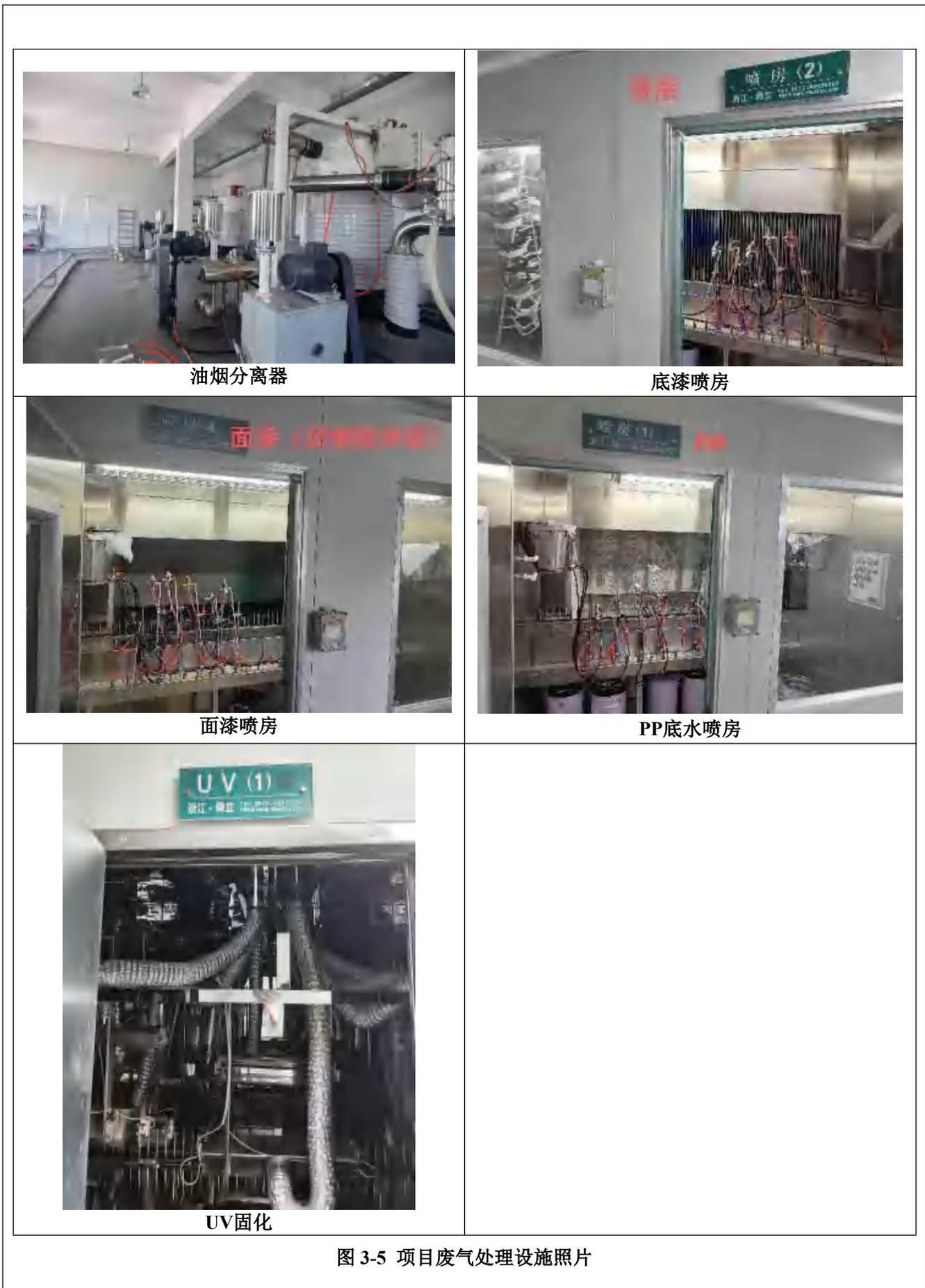
图 3-5 项目废气处理设施照片
