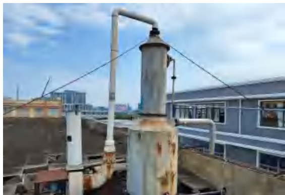
泡沫灭火剂加料混合搅拌、加料搅拌调 pH 值、灌装废气处理设施
