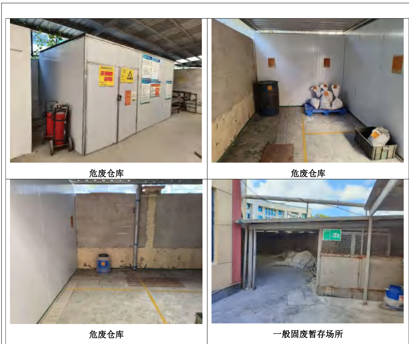
图 3-6 固废暂存场所照片
